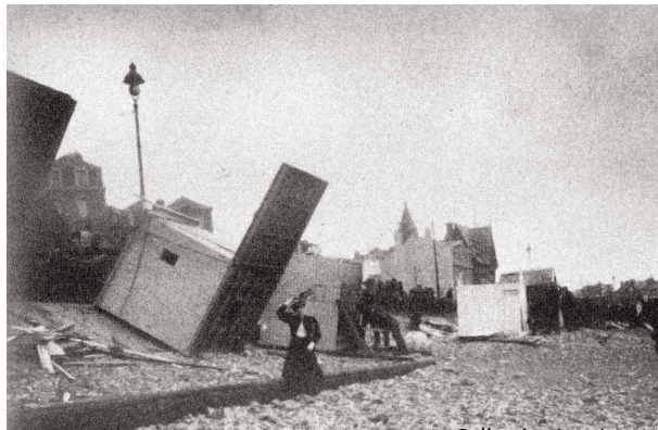
Figure 9 : Dégâts sur les plages du Havre.
