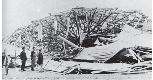
Figure 10 : Effondrement du panorama de Jeanne d'Arc le 11 novembre 1891.
