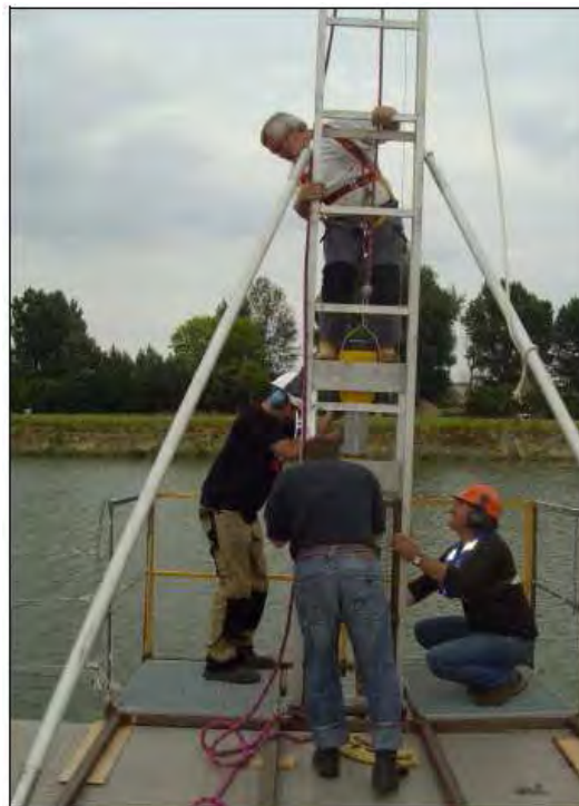
Figure 3. Carottier à percussion installé au bord de la barge LAMATRANS II.
