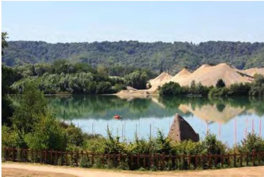
Photo 7 : Vue sur la carrière en activité depuis la base de loisirs de Jumièges. Entre les dunes de sable les engins mécaniques sont bien visibles.
