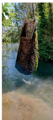
FIGURE E Filet collecteurs de déchets posé sur un exutoire du réseau d'assainissement.
