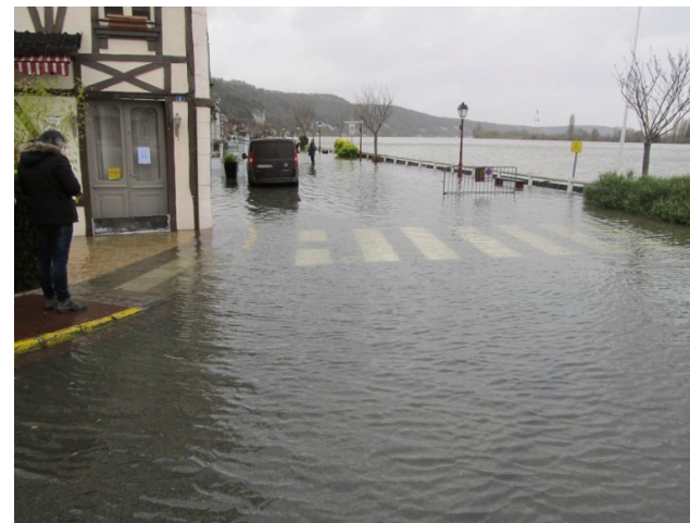
Inondations à La Bouille pendant la tempête Eleanor en janvier 2018 © Paris-normandie
