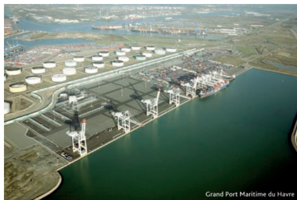
Figure 5. Le Terminal de France (Grand Port Maritime du Havre).
