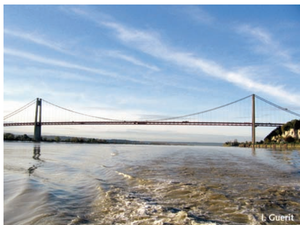
Figure 4. Le Pont de Tancarville.
