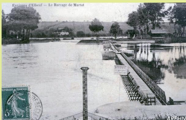
Figure A : Carte postale de l'ancien barrage à aiguille de Martot vue de la rive gauche
