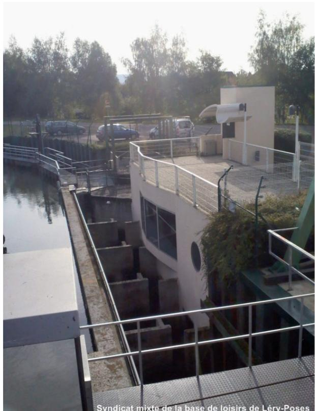
Figure 21: Passe à poisson du barrage de Poses
