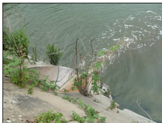
Photo 85. Rejet de l'usine de recyclage de carton de St Etienne-de-Rouvray.
