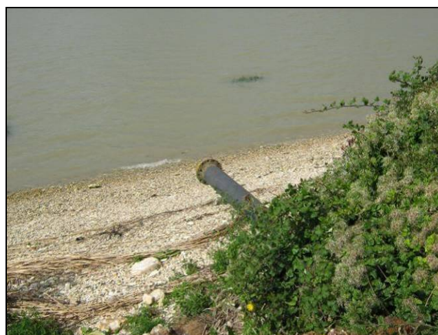
Photo 25. Connexion hydraulique côté fleuve de l'ancienne filandre (encart rouge sur la Figure 15).
