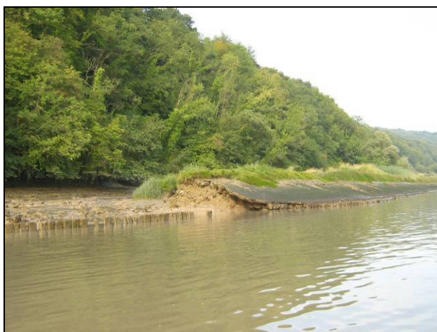
Photo 29. Digue de calibrage en dalles bétons (Vieux port.).
