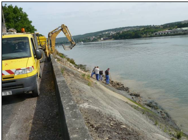
Photo 26. Réfection des dalles bétons du talus de berge (La Mailleraye-sur-Seine).
