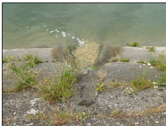
Photo 84. Rejet de la zone industrielle sous le pont de Brotonne (Rive droite).
