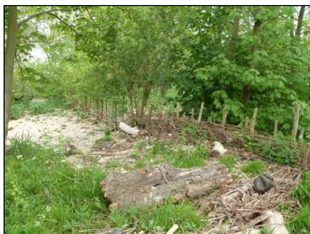
Photo 51. Piège à déchets : Epis sous forme de fascine (Hénouville).
