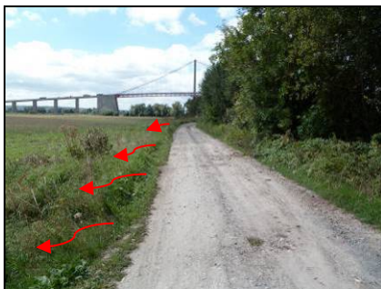
Photo 19. Talus plongeant (Amont du Pont de Tancarville - rive gauche).
