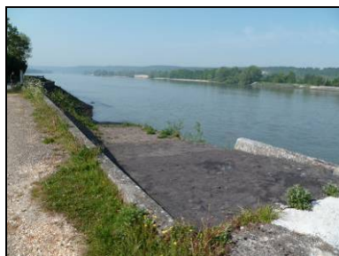
Photo 77. Cale de mise à l'eau (Quevillon, La Chaussée des vieux).
