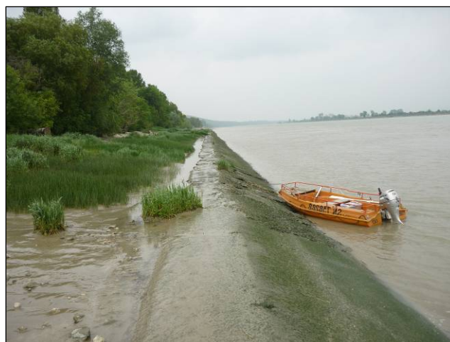
Photo 31. Vasières et groupements végétaux implantés derrière la digue de calibrage (Aizier).
