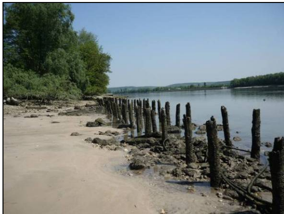
Photo 18. Exemple de vestige d'ouvrage : ancienne protection de berge (Beaulieu).
