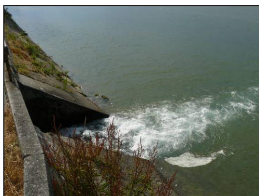
Photo 82. Ouvrage fixe : Pont cadre.
