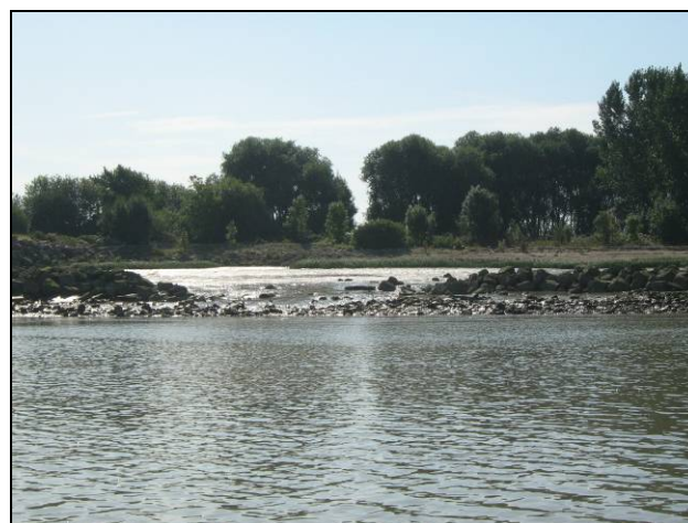
Photo 30. Digue de calibrage en enrochements non liés (Pont de Tancarville.).
