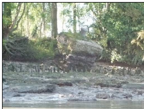
Photo 90. Exemple de vestige d'ouvrage : bite d'amarrage.
