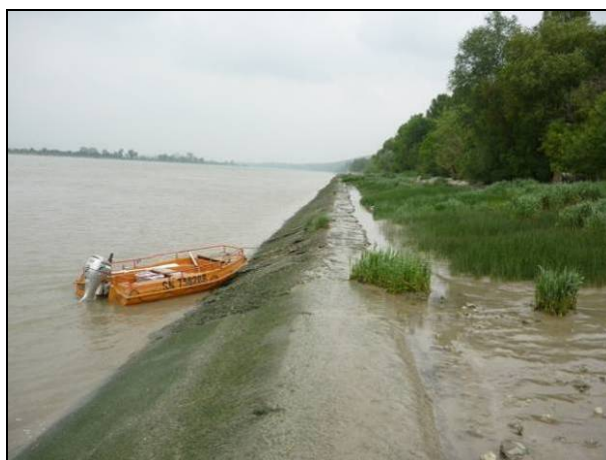
Photo 3. Digue de calibrage (Aizier).
