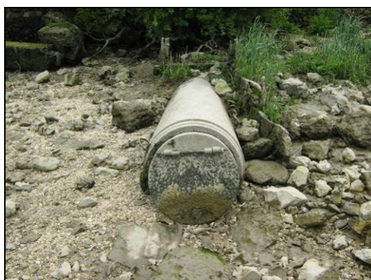
Photo 80. Ouvrage mobile : Clapet à marée.
