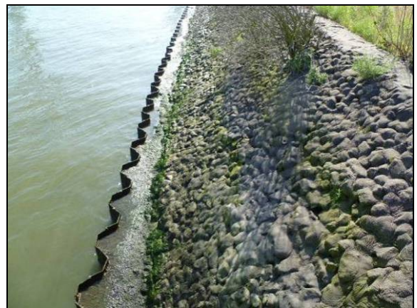
Photo 10. Exemple de protection du pied de berge : palplanche métallique (Presqu'île Rollet - Rouen).
