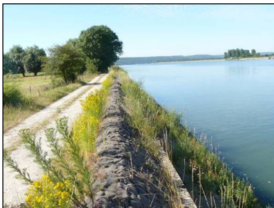
Photo 16. Digueron de protection contre les inondations (Vatteville-la-Rue).
