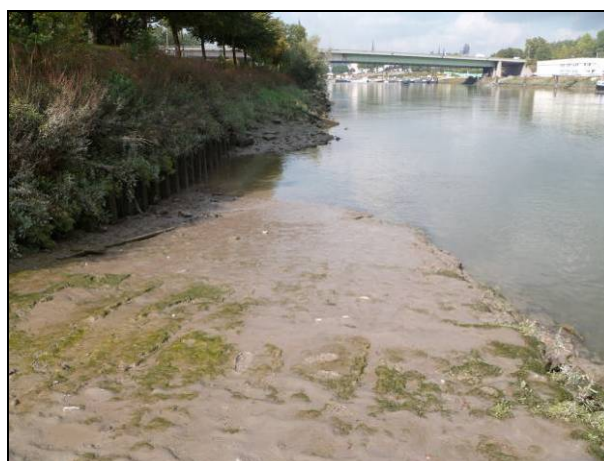
Photo 93. Cale à bateau de l'Ile Lacroix (Rouen) : partie inférieure de la cale présentant un dépôt limono-vaseux important.
