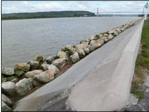
Photo 7. Exemple de protection du pied de berge : enrochements non liés (Aval du Pont de Tancarville - rive gauche).
