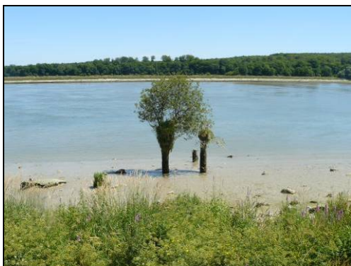
Photo 89. Exemple de vestige d'ouvrage : anciens pieux de ponton.
