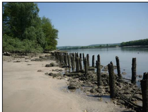
Photo 88. Exemple de vestige d'ouvrage : ancienne protection de berge.
