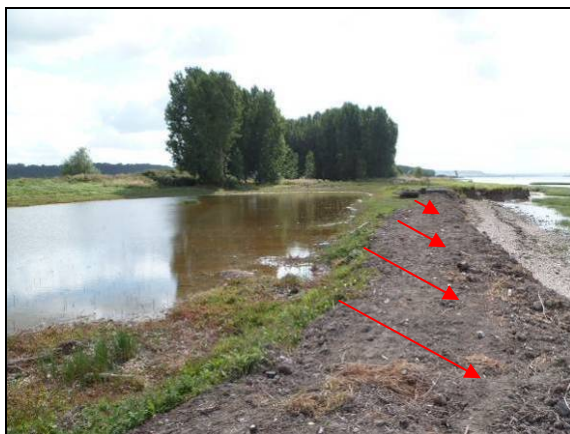
Photo 23. Berge présentant un substrat d'origine anthropique (Aval du Pont de Tancarville – rive gauche).
