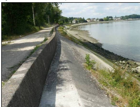
Photo 17. Muret de protection contre les inondations (la Mailleraye sur Seine).
