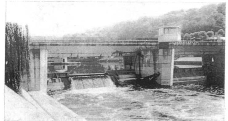
Fig. 1.21. — Barrage de Bougival à vanne-segment.
