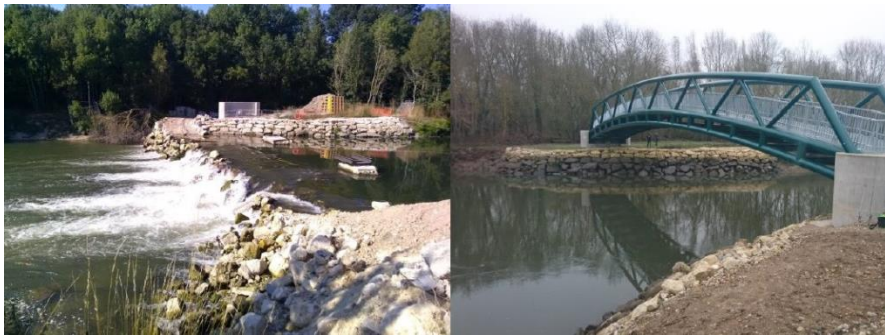
Figure 14: Ouvrage de Martot avant et après effacement (décembre 2018) (Source: (FDAAPPMA27, 2019))
