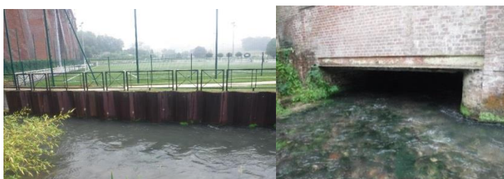
Figure 10: Aménagement des berges et rectification de l'Austreberthe (source: SIRAS)
