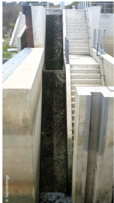
➔ Rampe à anguille accolée au barrage de Poses
