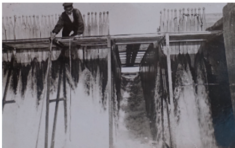
➡ Echelle à poissons sur le barrage de Martot en 1895
