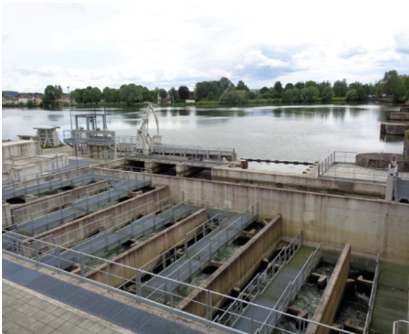
➡ Passe à poisson sur le barrage de Poses
