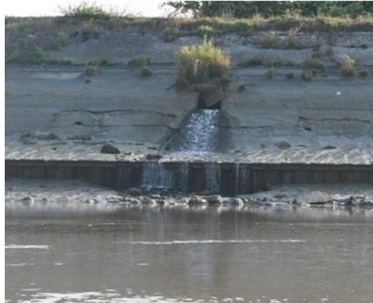
*Figure 22. Exemple de clapet dysfonctionnel*
