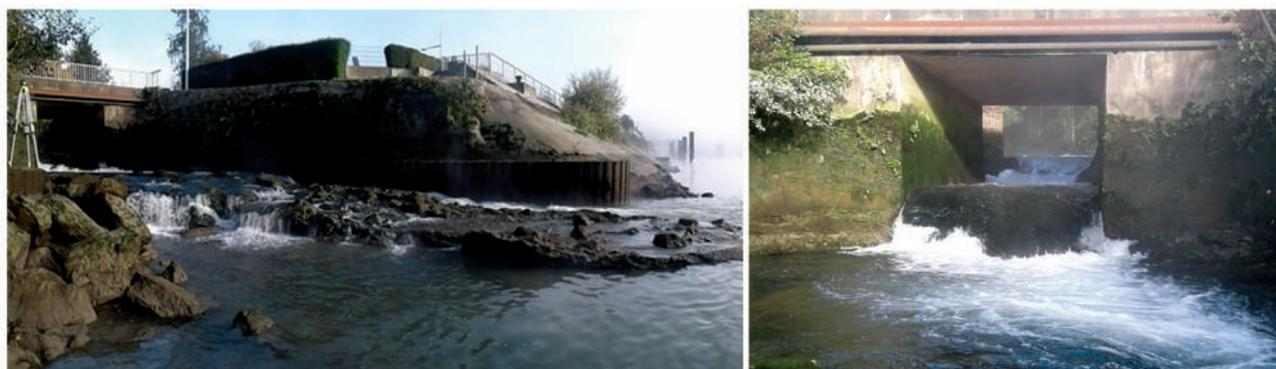
**Figure 4 : Confluence entre l'Austreberthe et la Seine à Duclair. La confluence est sous l'influence de la marée entraînant temporairement une déconnexion au fleuve (à gauche). Cette déconnexion à marée basse est accentuée par la présence d'un ouvrage (à droite). Source : GÉObs**
