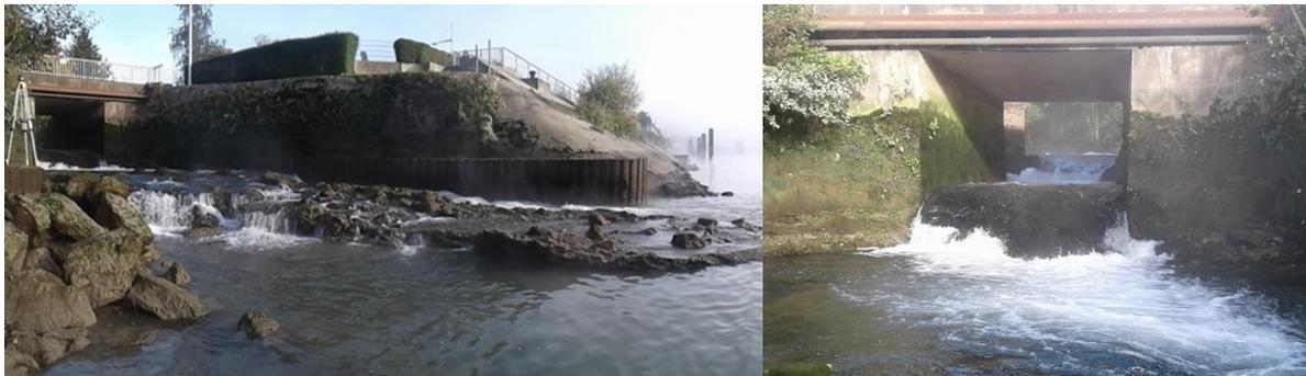
Figure 8: confluence entre l'Austreberthe et la Seine à Duclair. La confluence est sous l'influence de la marée entraînant temporairement une déconnexion au fleuve (à gauche). Cette déconnexion à marée basse est accentuée par la présence d'un ouvrage (à droite). Source: GéObs
